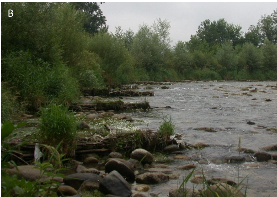
Figure 2-13: Succession d'épis plongeants sur les berges de l'Adour (A) pendant les travaux (automne 1999) et (B) 4 ans après les travaux © CFPF Bonin et al. 2013
