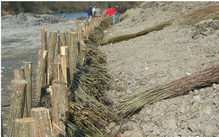
Figure 3-12 : Pieds des branches vivantes prêtes à être enfouies dans le sol à l'arrière de la fascine dans le talus © Pierre-André Frossard
