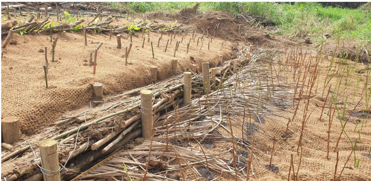
Figure 3-14: Installation d'une fascine vivante de Piper dilatatum , et d'une fascine morte ensemencée de graines d'une espèce indigène d'arbre de ripisylve ( Inga ingoides ) en pied de berge de la rivière Lézarde Petit Bourg, Guadeloupe, Novembre 2022. © Pierre Raymond.
