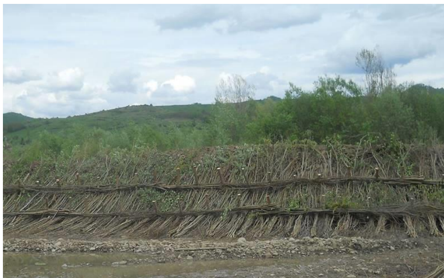
Figure 2-33: Matelas en fascines réalisés en Roumanie © André Evette
