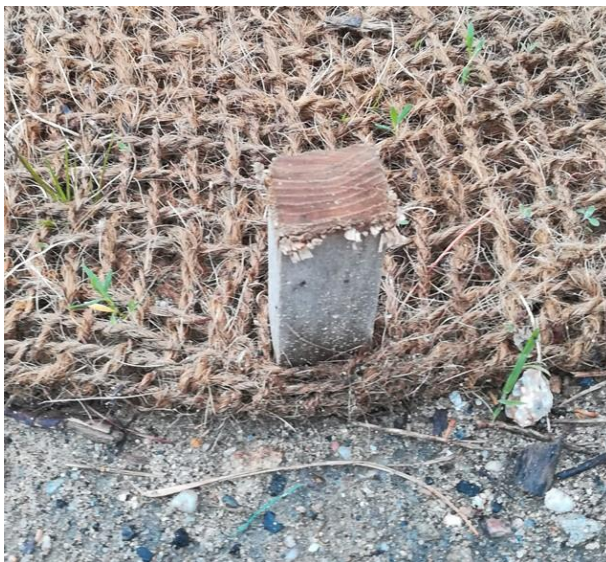
Figure 3-5: Exemple d'agrafe en bois utilisé pour le maintien de géotextile ©André Evette
