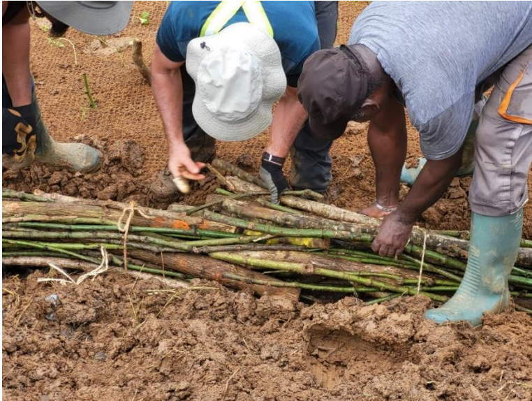
Figure 3-13: Zone de chevauchement entre deux fagots ©André Evette
