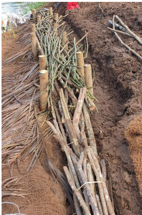
Figure 3-14: Installation d'une fascine vivante de Piper dilatatum , et d'une fascine morte ensemencée de graines d'une espèce indigène d'arbre de ripisylve ( Inga ingoides ) en pied de berge de la rivière Lézarde Petit Bourg, Guadeloupe, Novembre 2022. © Pierre Raymond.
