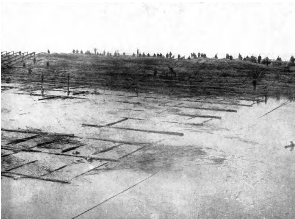
Figure 1-3: Tapis subaquatique tissé sur les berges du Mississippi à la fin du 19 ème Siècle, « la portion au premier plan est lestée et prête à être coulée » (US Army 1922)
