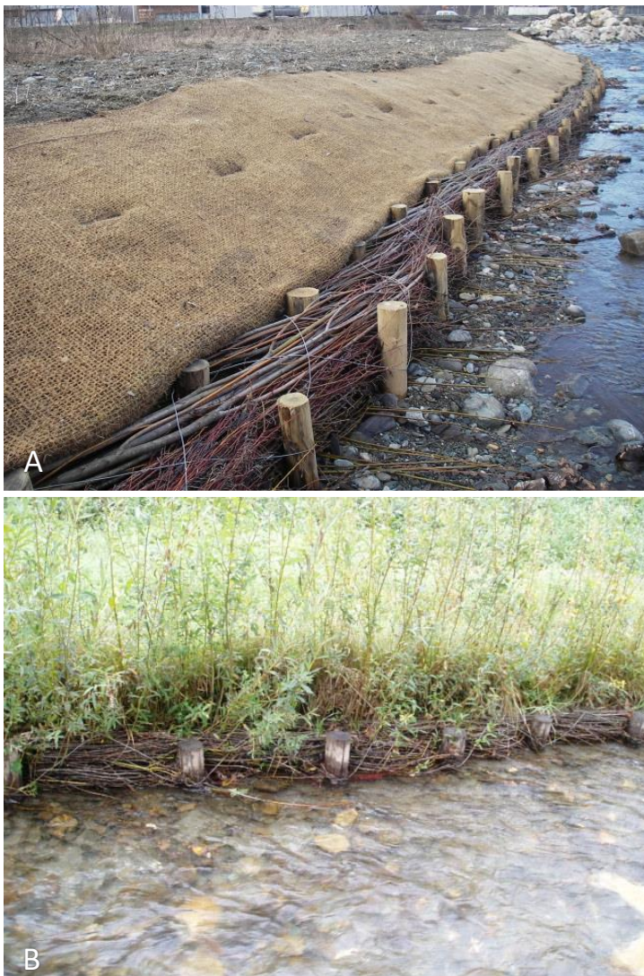
Figure 2-1: Fascines de pied de berge sur le Vorz (A) juste après installation en 2007 © Belleudy et (B) durant la saison de végétation suivant la mise en place © André Evette
