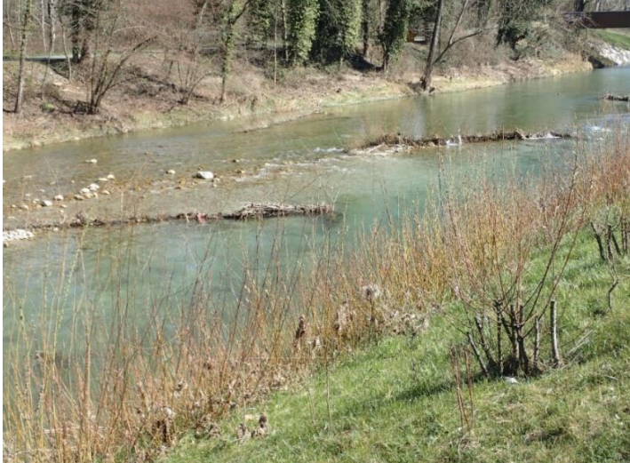
Figure 2-19: Fascines de diversification en diagonal réalisées sur la Leysse © André Evette
