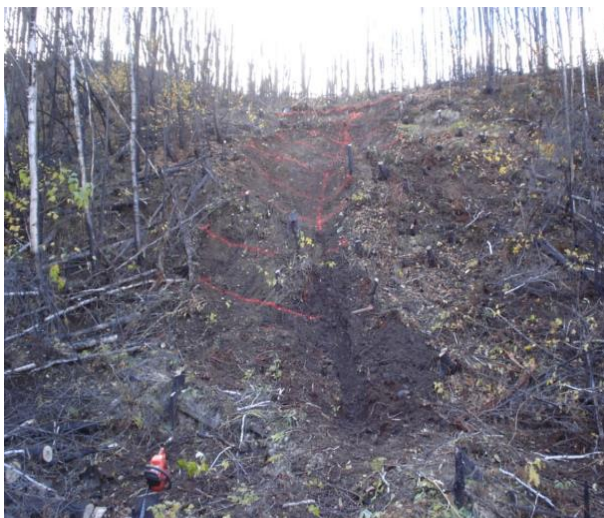
Figure 2-26: Tracé peint sur la pente © Terra Erosion Control
