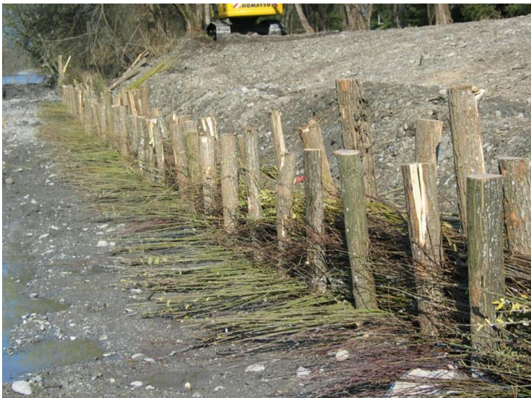
Figure 2-3: Branches anti-affouillement pour la protection de la fascine © Pierre André Frossard
