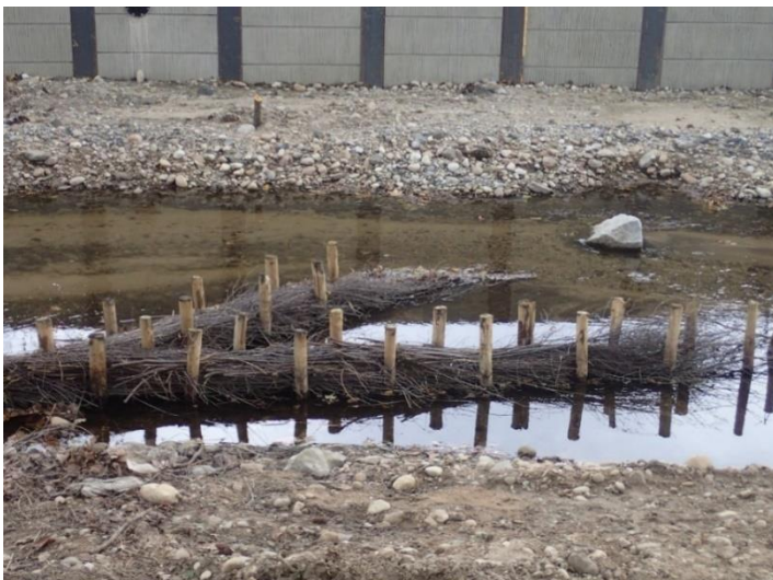
Figure 2-17: Fascines de diversification en chevron réalisé sur l'Yzeron ©André Evette
