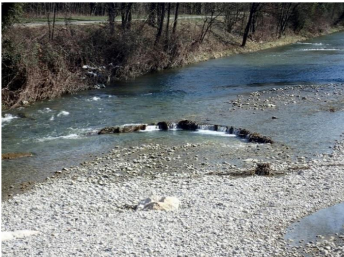
Figure 2-18: Fascine de diversification en arche réalisée sur la Leysse © André Evette
