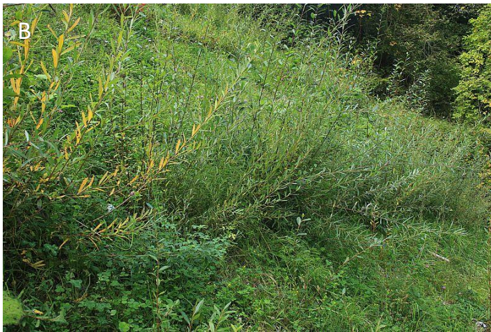
Figure 2-31: Fascines de pente à St Gingolph juste après l'installation (A) et après développement (B) © Pierre-André Frossard
