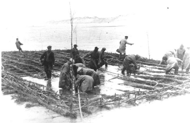
Figure 2-22: Mise en place d'un zinkstuk (plateforme à échouer) – Vieland, Pays-Bas (années 1930) © Islander – Dirk Bruin
