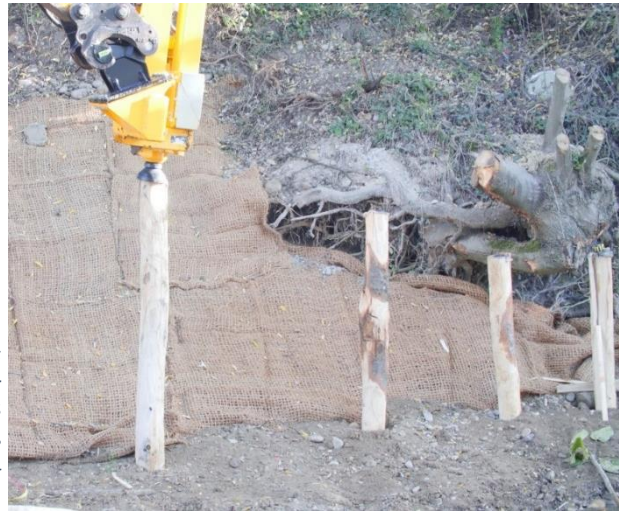
Figure 3-8: Battage mécanique des pieux sur la Bourbre © Marie Didier Restauration de la continuité écologique de la Bourbre-maîtrise d'ouvrage : les Autoroutes APRR et AREA
