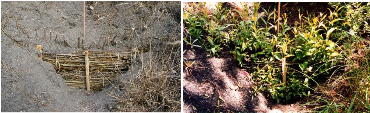
Figure 2-21: Fascines de lit de ravine juste après installation et quelques mois après © Freddy Rey
