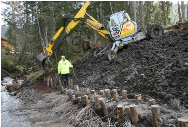
Construction de la fascine de pied de berge surmontée des lits de plants et plançons – Mai 2012 © Pierre-André Frossard
