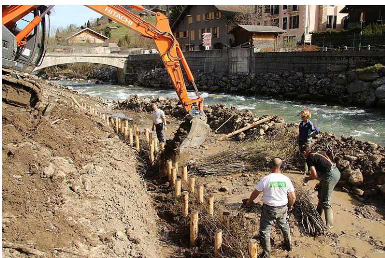
Figure 2-6 : Ajout de matériaux terreux sur l'ouvrage en phase d'être terminé afin de limiter le dessèchement des branches vivantes
