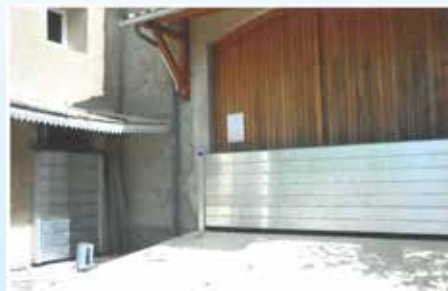
Photographie 1 : mise en place de batardeaux (CA26).
